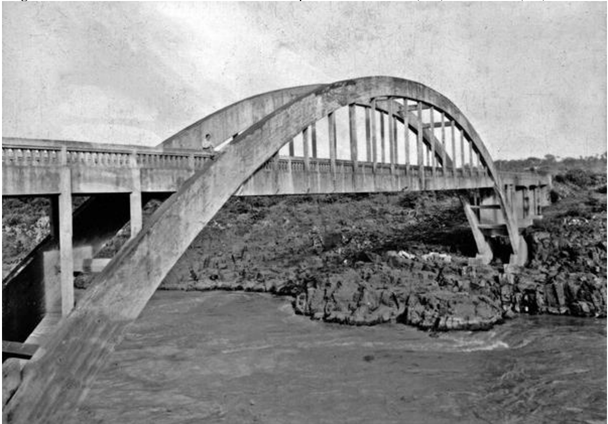
Figura 04: Ponte sob o Rio Paranaíba entre os municípios de Santa Vitória (MG) e São Simão (GO) em 1953.
