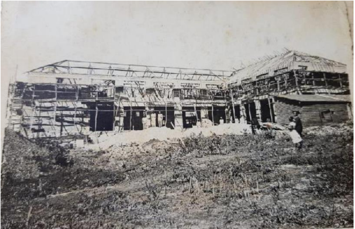
Figura 21: Etapa inicial da Construção do Colégio Imaculada Conceição em Ceres-GO, no final da década de 1940.
