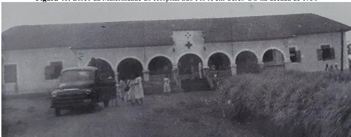
Figura 46: Bloco da Maternidade do Hospital São Pio X em Ceres-GO na década de 1950
