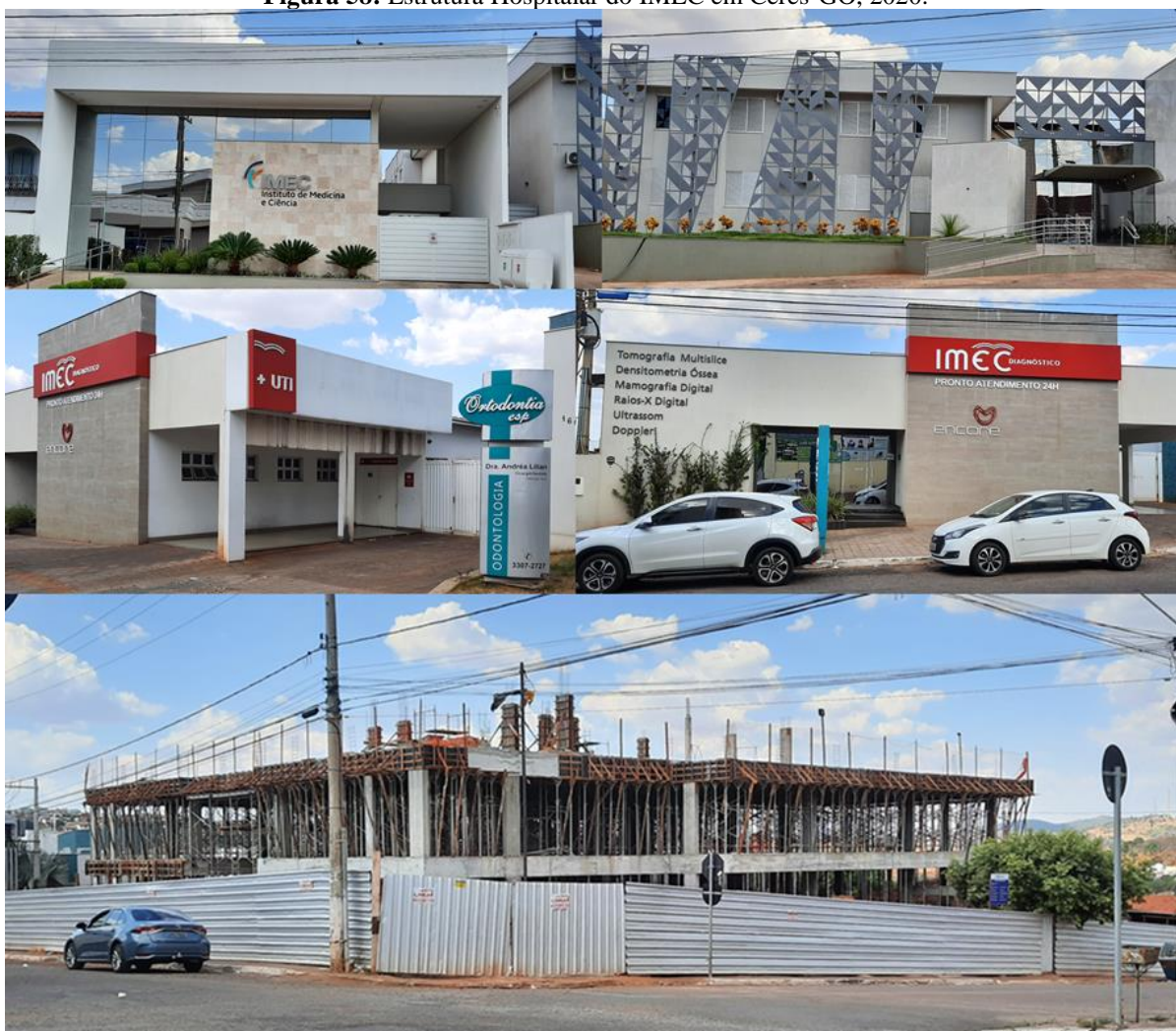
Figura 58: Estrutura Hospitalar do IMEC em Ceres-GO, 2020.
