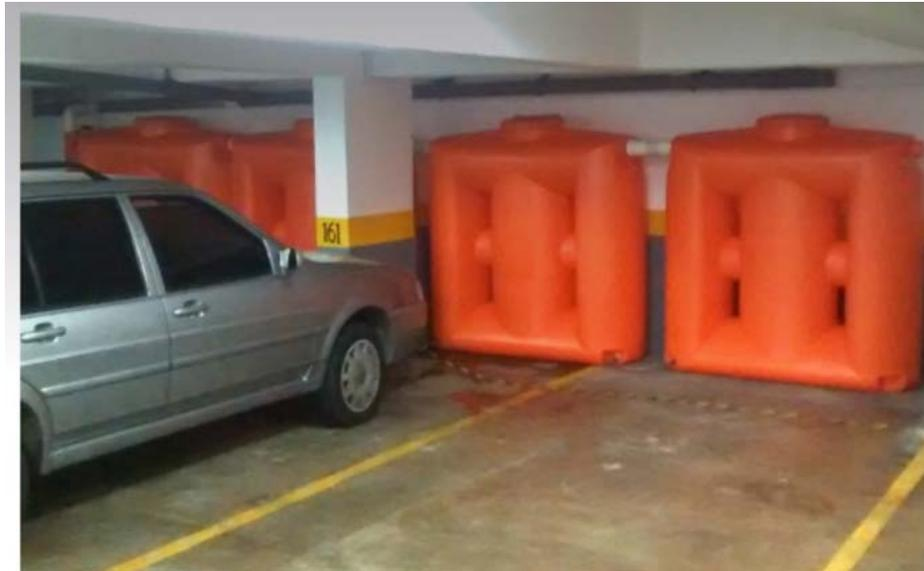
Figura 4.5- Reservatório inferiores comerciais para garagens
