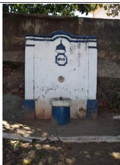
Chafariz da Corte Real - Sede
