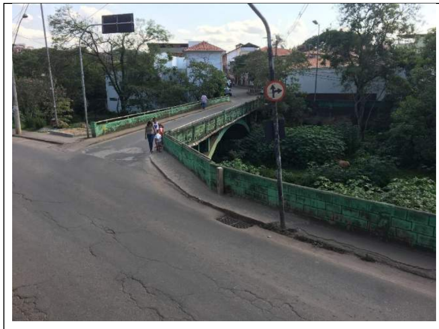
Figura 68 - Fotos da ponte da Igreja
