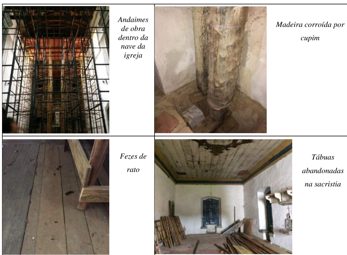
Figura 140 - Fotos do interior da Igreja da Lapa - Ravena
