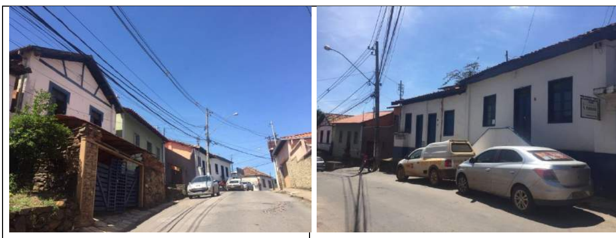
Figuras 118 e 119 – Fotos casas próximas a Igreja Nossa Senhora da Conceição
