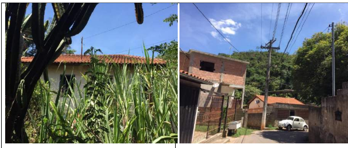
Figuras 76 e 77 - Fotos das casas de Pompéu
