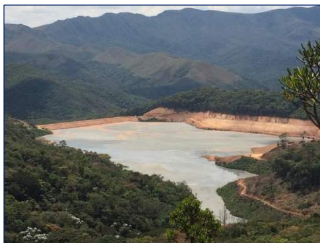
Figura 85 – Foto barragem de rejeitos AngloGold Ashanti
