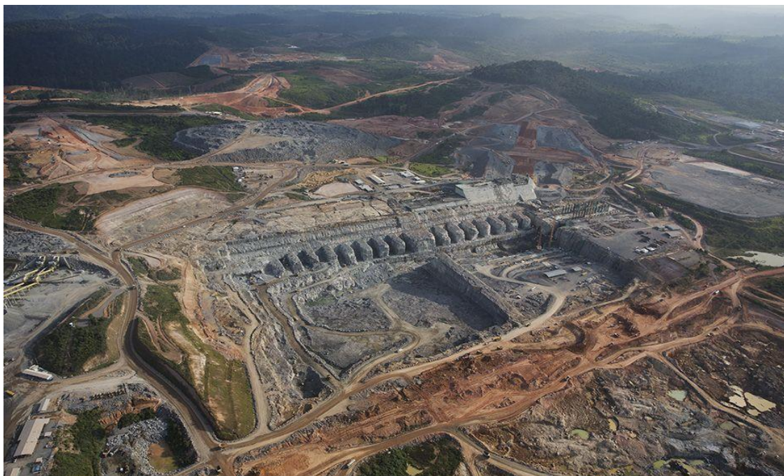
Figura 5– Imagem aérea das obras da Usina Hidrelétrica de Belo Monte
