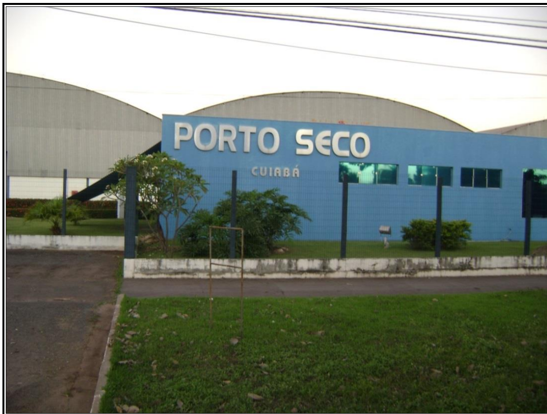
Figura 4 - Instalações do Porto Seco em Cuiabá-MT
