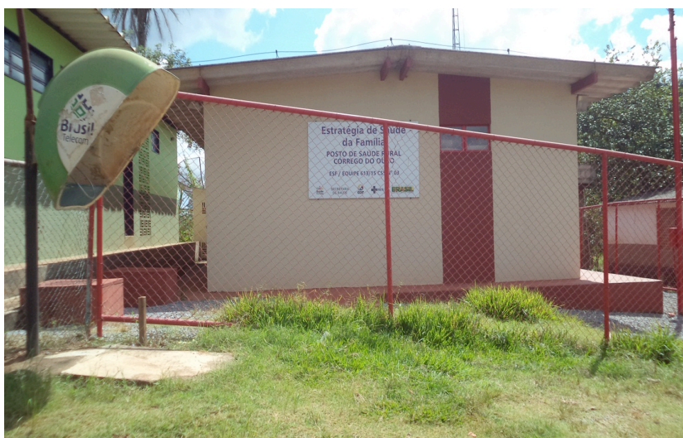
Figura 21 – Posto de Saúde do Córrego do Ouro. Foto: Ronaldo Neves Ferreira.
