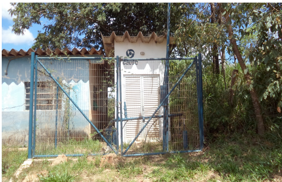
Figura 22 - Poço Artesiano do Córrego do Ouro Foto: Ronaldo Neves Ferreira.
