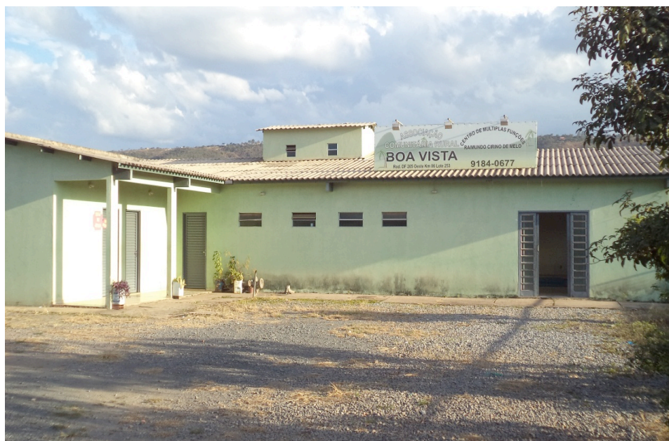
Figura 18 – Centro Comunitário da Boa Vista. Foto: Ronaldo Neves Ferreira.
