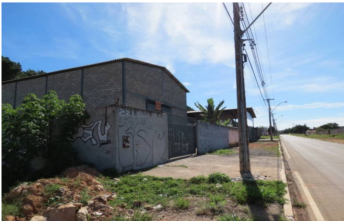
Figura 37 – Área industrial. Paranoá, Distrito Federal, Brasil.
