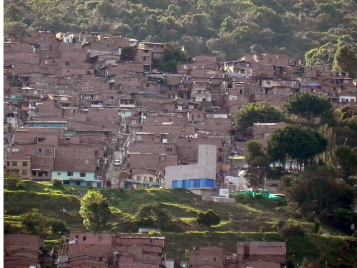
Figura 6 – Comunidade El Progreso, destaca-se o aclave acentuado e moradias auto construídas como dizem os arquitetos locais, é difícil ver construções rebocadas e pintadas (Foto do autor).
