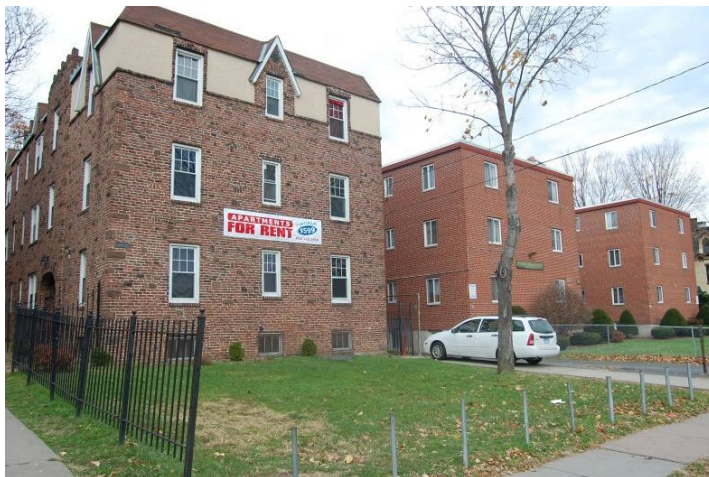
Figura 19 – Edifícios residenciais multifamiliares com oferta de aluguel (foto do autor).
