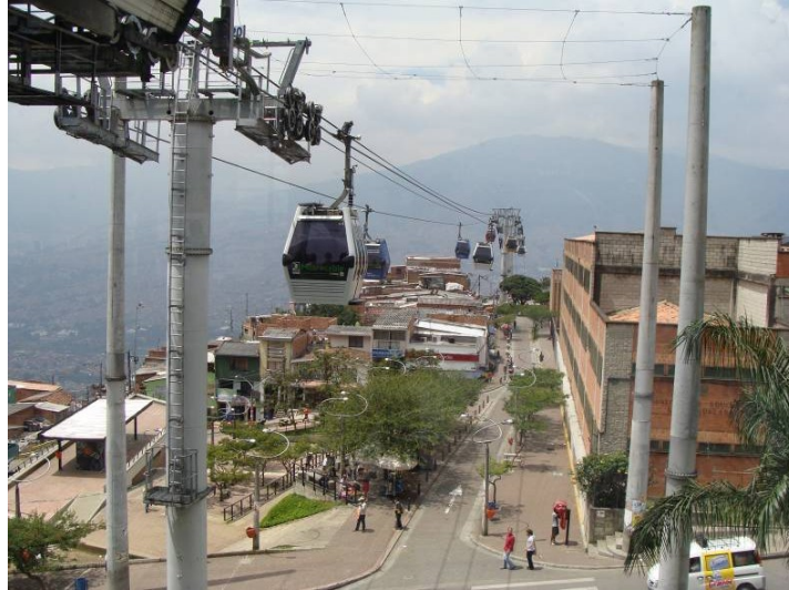
Figura 11 - Postes de iluminação próximos à estação do metrocable e da biblioteca Espanha (Foto do autor).
