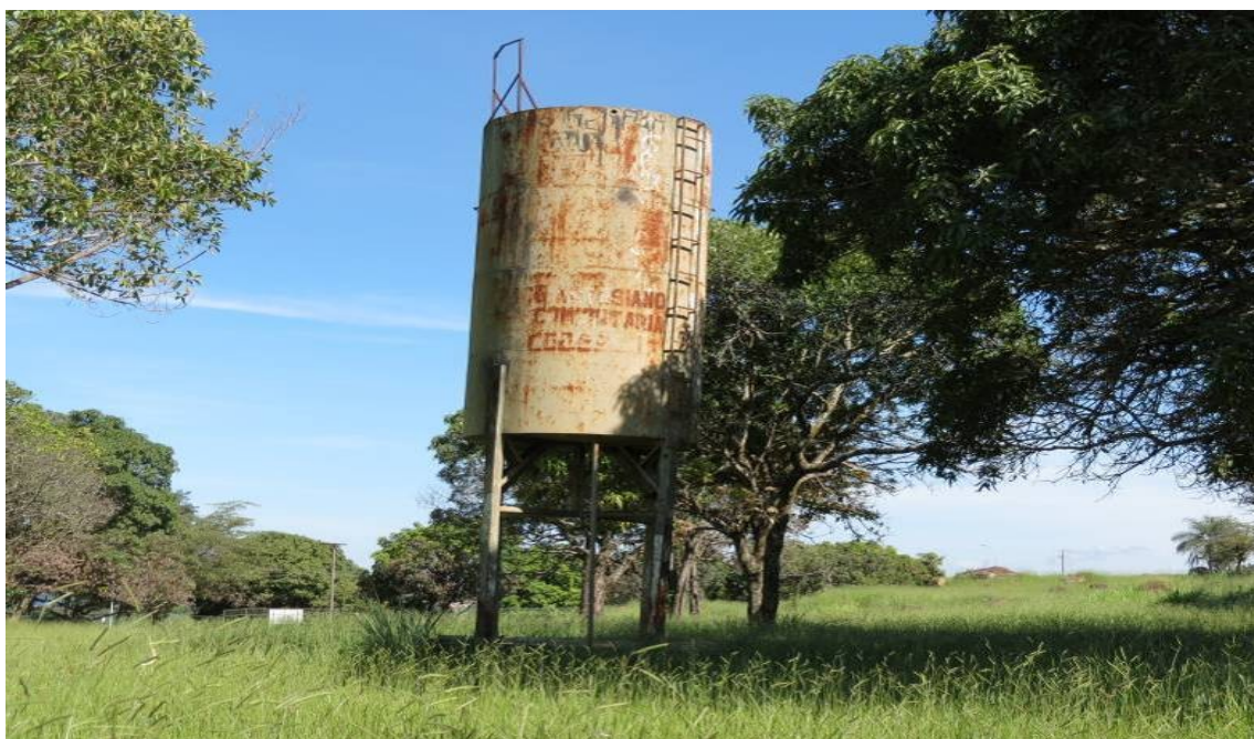
Figura 36 – Foto de uma caixa d’água que restou do antigo acampamento do interior do Parque Vivencial. Paranoá, Distrito Federal, Brasil.
