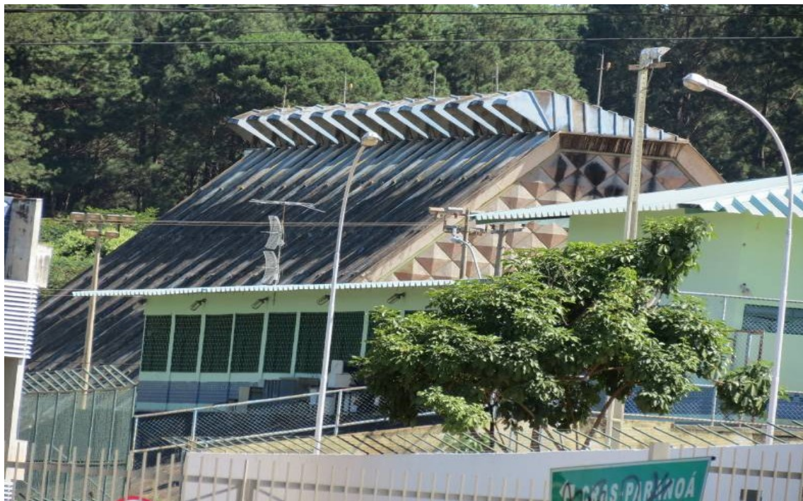
Figura 46 – Postes de aço com braço curvo e luminária única. Paranoá, Distrito Federal, Brasil.
