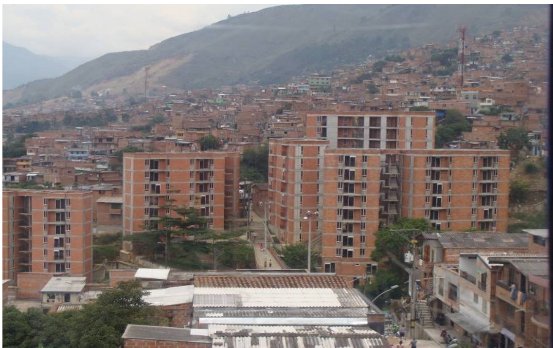
Figura 26 – Edifícios residenciais próximos à linha do teleférico da zona nororiental. Medellín, Colombia.
