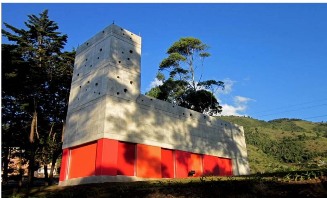
Figura 21 – CAI periférico durante o dia, as aberturas redondas na fachada servem para que policiais possam disparar suas armas em segurança em caso de ataque hostil. Medellín, Colombia.
