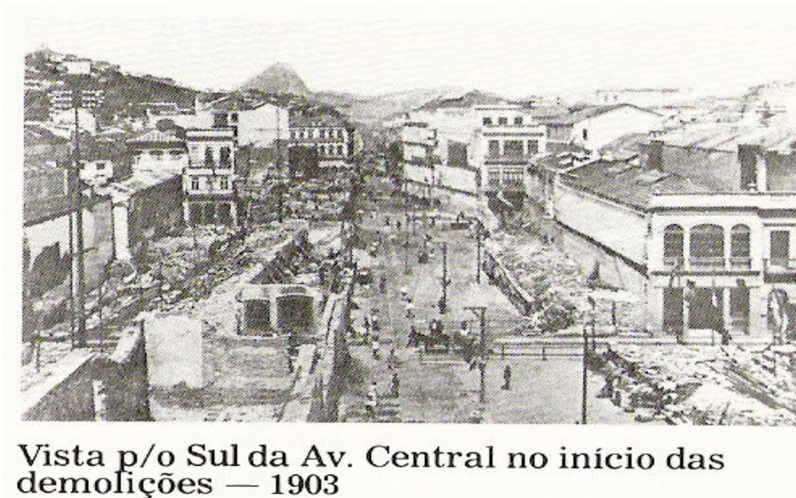
Figura 7 – Foto do início das demolições de cortiços para abertura da Avenida Rio Branco. Rio de Janeiro, Brasil.
