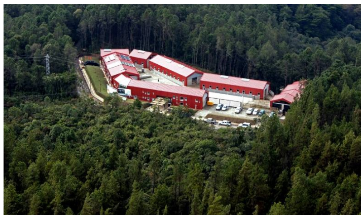
Figura 4 – Forte de carabineros de Santa Elena, primeiro a ser construído, visa manter a segurança do parque Arví (Foto de Andres Montoya).
