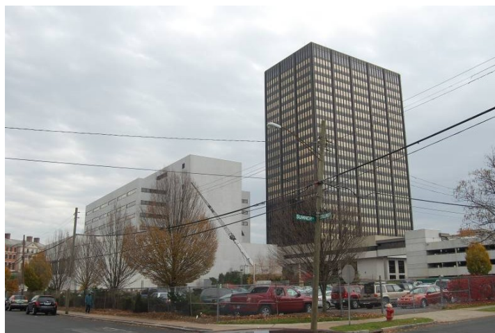
Figura 22 – Hospital que delimita o bairro na direção oeste.
