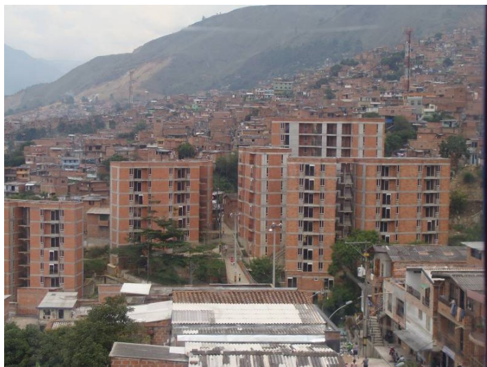
Figura 13 – Edifícios residenciais próximos à linha do teleférico da estação do metrocable de Santo Domingo (Foto do autor).
