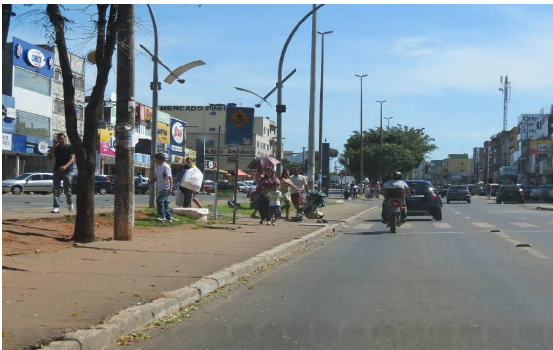
Figura 48 – Postes de concreto com luminárias duplas, instalados em via com canteiro central. Avenida Paranoá. Paranoá, Distrito Federal, Brasil.
