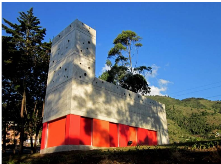
Figura 1 - CAI periférico durante o dia, as aberturas redondas na fachada servem para que policiais possam disparar suas armas em segurança em caso de ataque hostil (Foto de Andres Montoya).
