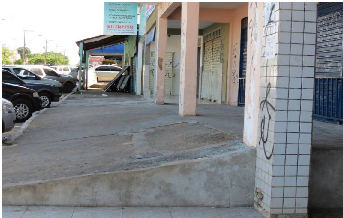
Figura 42 – Foto do detalhe do desnível da Avenida Paranoá. Paranoá, Distrito Federal, Brasil.
