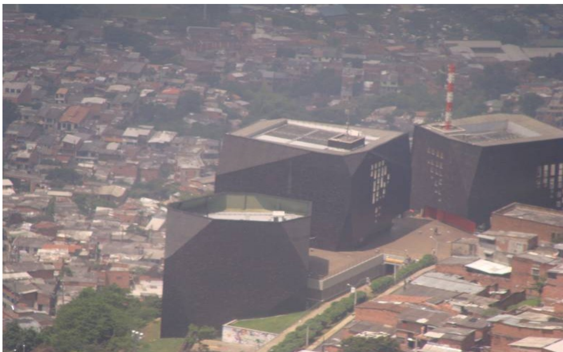
Figura 24 – Complexo da biblioteca Espanha visto do interior do teleférico. Medellín, Colombia.
