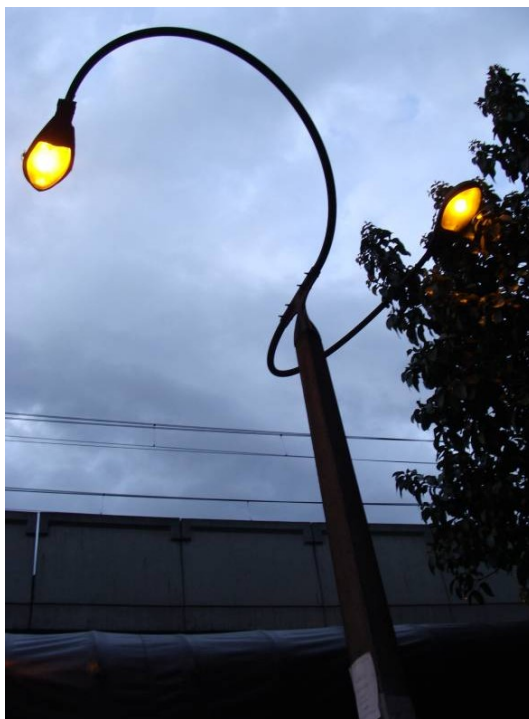
Figura 10 - Poste de iluminação próximo ao metrô elevado da cidade, observa-se a baixa luminosidade das lâmpadas bem como a proximidade de árvores (Foto do autor).
