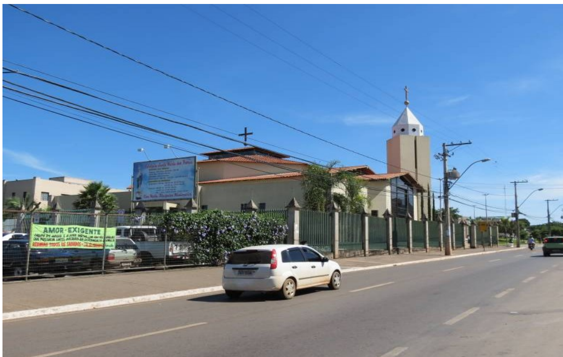
Figura 47 – Postes de concreto com braço metálico curvo e luminária simples, adotado em via de mão única. Paranoá, Distrito Federal, Brasil.
